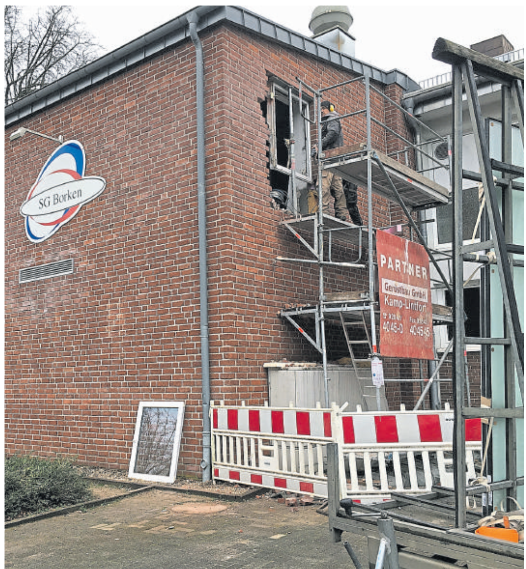
Das Gufi-Gebäude bekommt eine Außentreppe, damit der Gymnastikraum im Obergeschoss erreichbar bleibt. Auf der hier nicht sichtbaren Rückseite gibt es einen Durchbruch für einen zusätzlichen Eingang zum Erdgeschoss.
