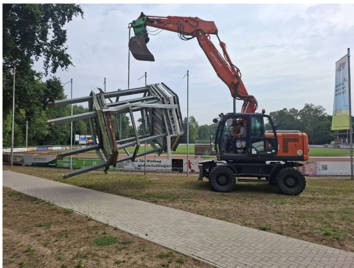
Unbarmherzig griff der Bagger zu und räumte ab.
