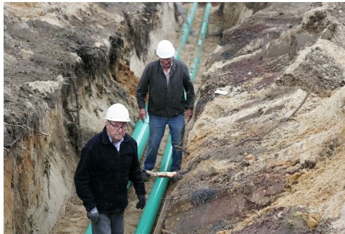
Die Rohre werden verlegt.
